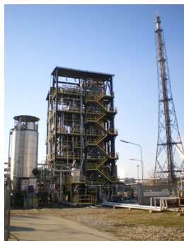
Pilote Fischer-Tropsch sur la raffinerie ENI de Sannazzaro
